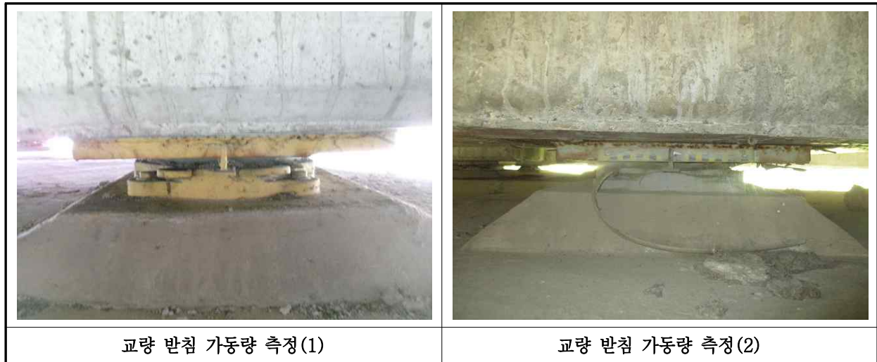
【사진 1.3.17】 교량받침 이동량 측정
