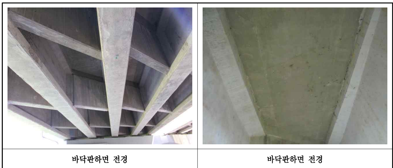
【사진 1.3.2】 바닥판하면 전경
