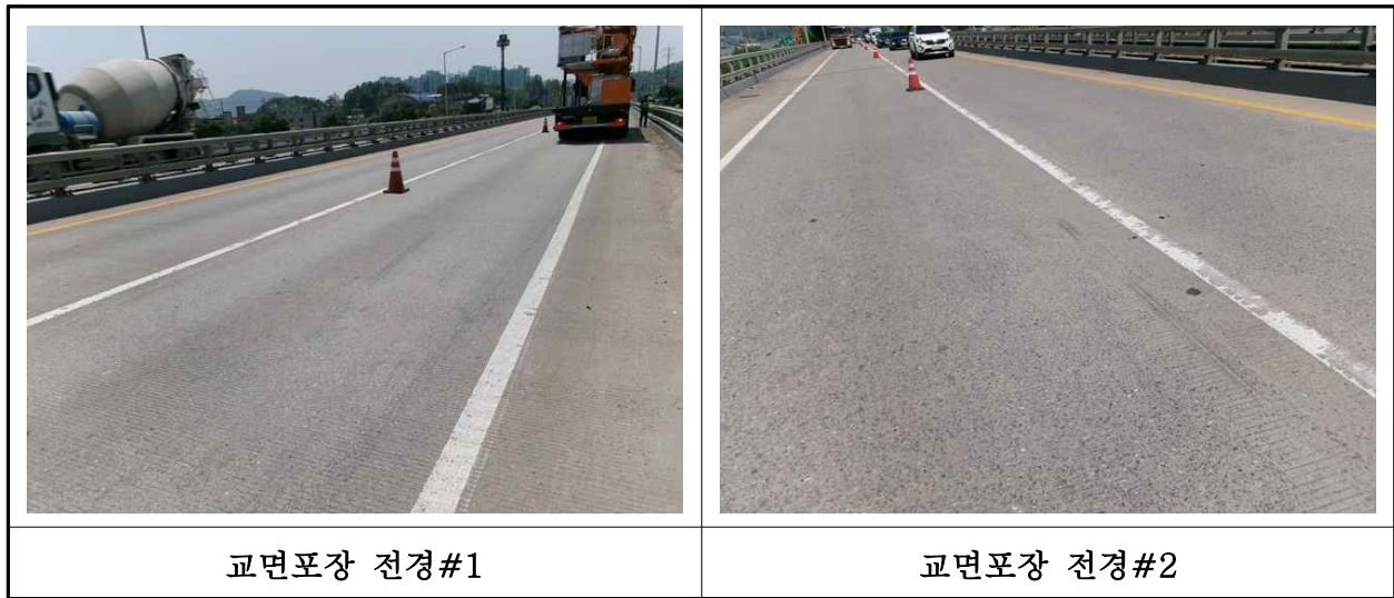
【사진 1.3.21】 교면포장 전경
