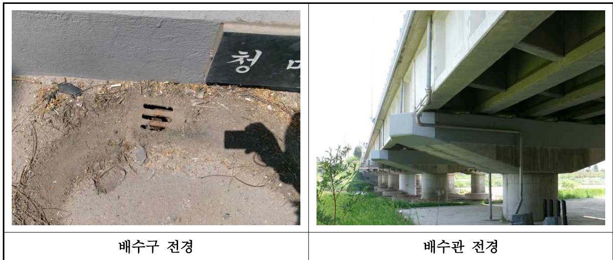
【사진 1.3.23】 배수시설 전경
