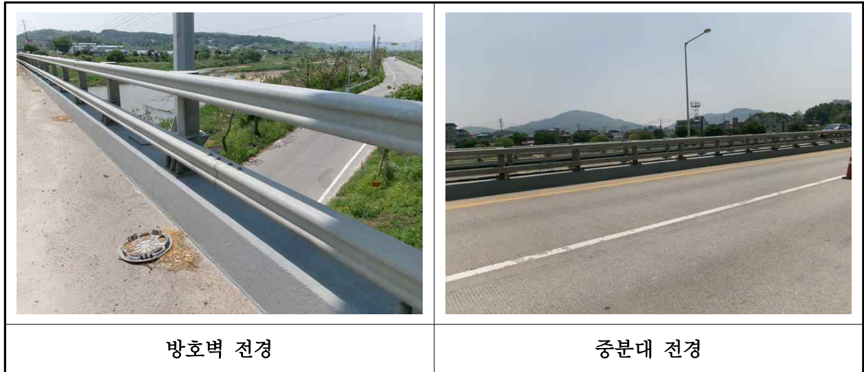
【사진 1.3.25】 방호벽 및 중앙분리대 전경
