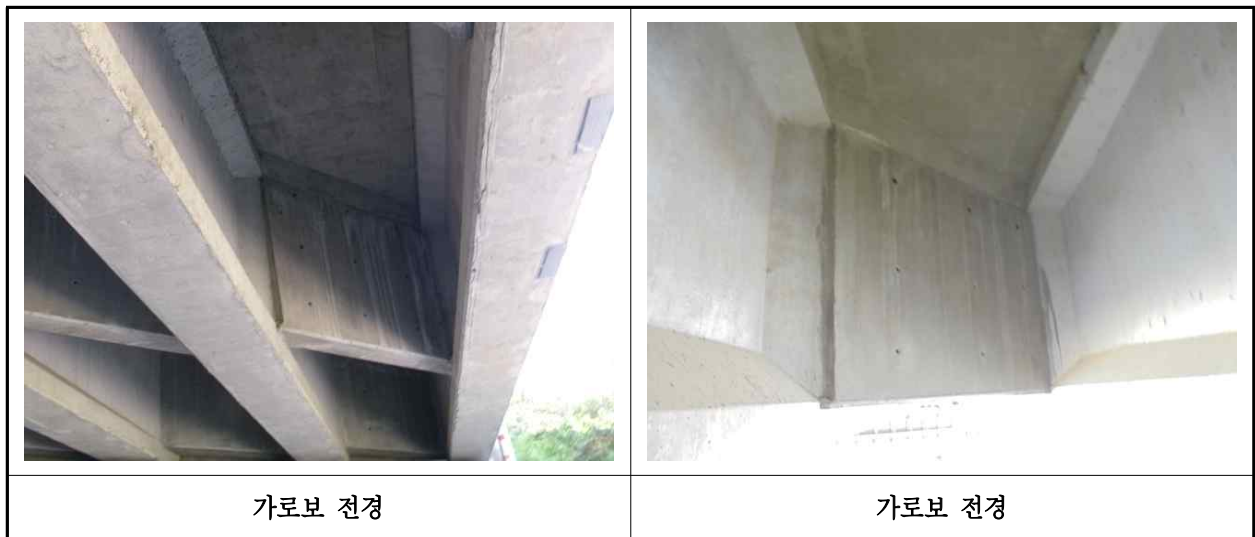
【사진 1.3.6】 가로보 전경
