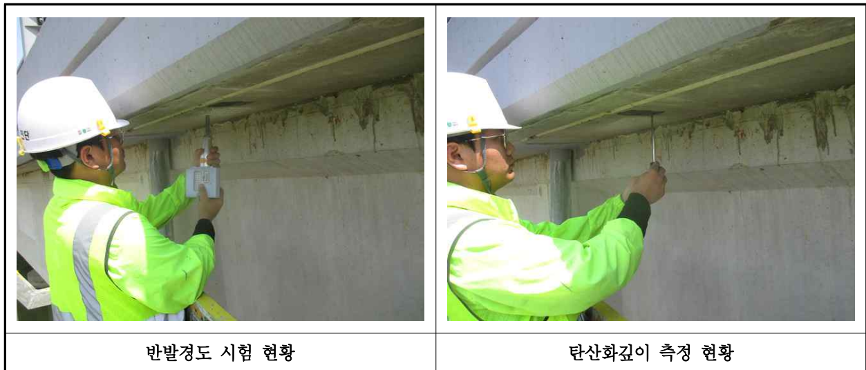
【사진 1.4.1】 콘크리트 내구성조사 현황
