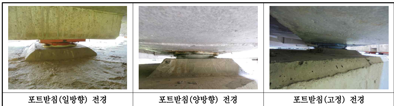
【사진 1.3.14】 교량받침 전경
