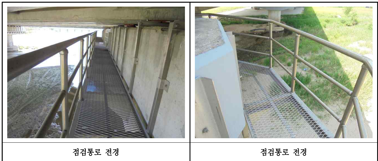
【사진 1.3.27】 교량 점검시설 전경
