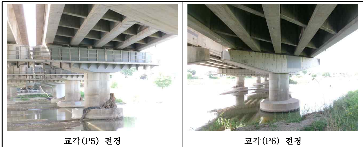
【사진 1.3.10】 교각 전경
