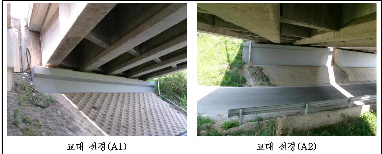
【사진 1.3.8】 교대 전경
